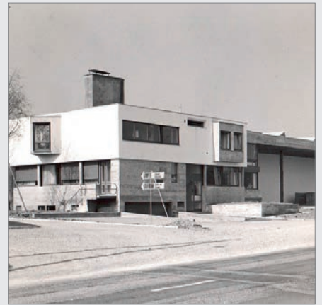
Le nouveau bâtiment à Rümlang dans les années 60 Der Neubau in Rümlang in den 60er-Jahren
